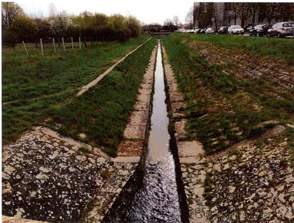
Betonozott, egyenes mederben futó patak, a rézsűben taposott gyomtársulás.
